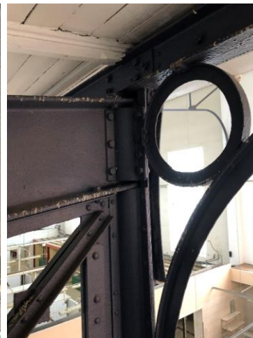
Foto Nr. 37 Kolonnas un Dubult T40 sijas mezgls.
