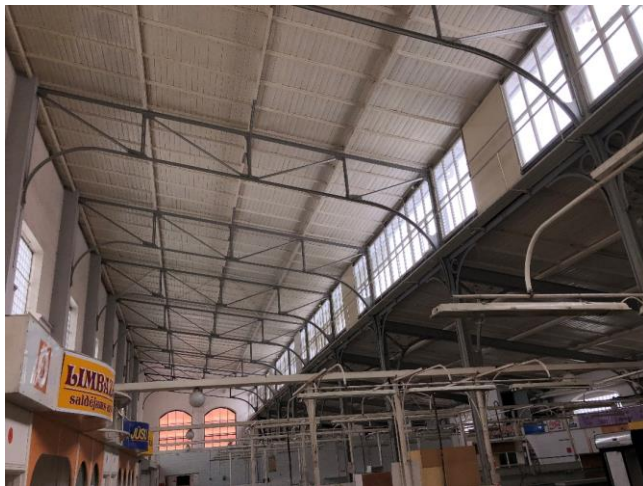
Foto Nr. 4 Virsgaismas daļas jumta konstrukcija.
