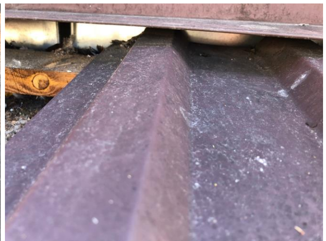
Foto Nr. 23 Neblīvs kores mezgls, putina iekšā sniegu zem seguma.
