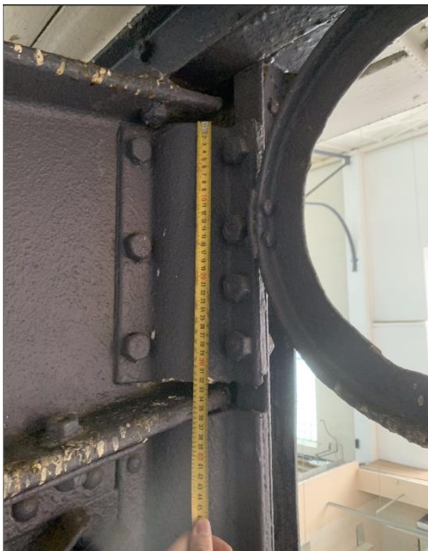
Foto Nr. 40 Kolonnas un Dubult T40 sijas mezgls.
