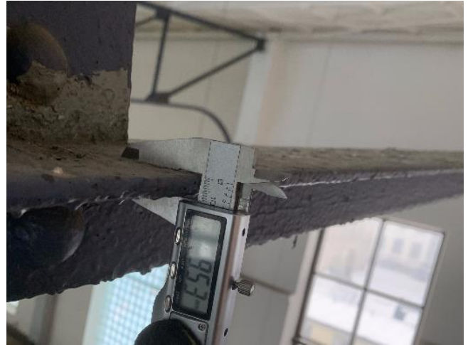
Foto Nr. 42 Kopnes atgāžņu un apakšjoslas savienojuma mezgls. Foto Nr. 43 Kopnes apakšjoslas L profils t-9mm.
