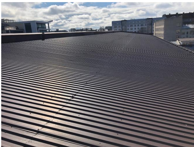
Foto Nr. 16 Jumta segums-profils T20.
