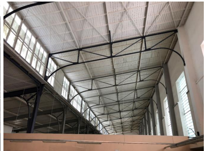
Foto Nr. 5 Virsgaismas daļas jumta konstrukcija.
