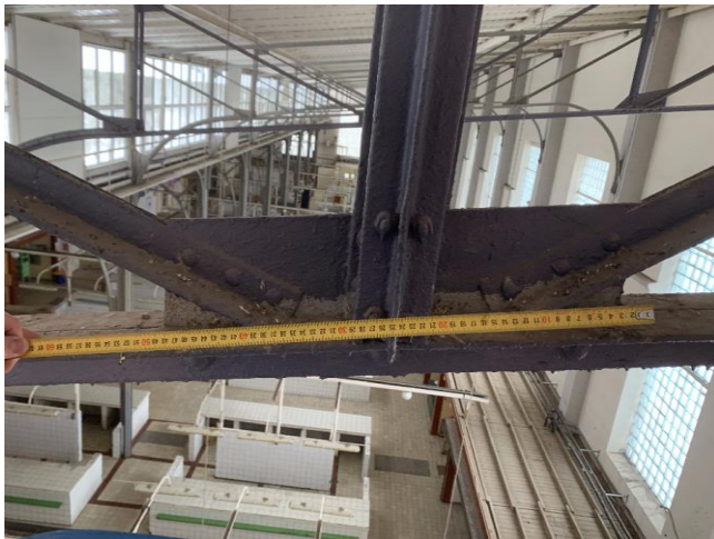
Foto Nr. 42 Kopnes atgāžņu un apakšjoslas savienojuma mezgls. Foto Nr. 43 Kopnes apakšjoslas L profils t-9mm.
