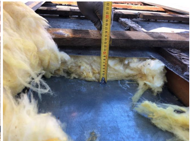
Foto Nr. 19 Siltumizolācija virs esošā seguma b-80mm.
