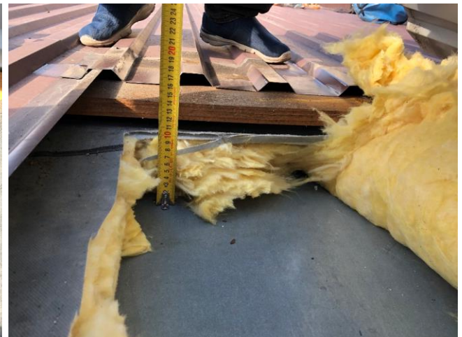
Foto Nr. 27 Minerālvate b-80mm virs vecā jumta seguma.
