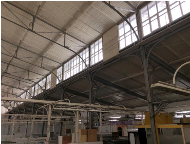
Foto Nr. 6 Virsgaismas un zemās daļas jumta konstrukcija.
