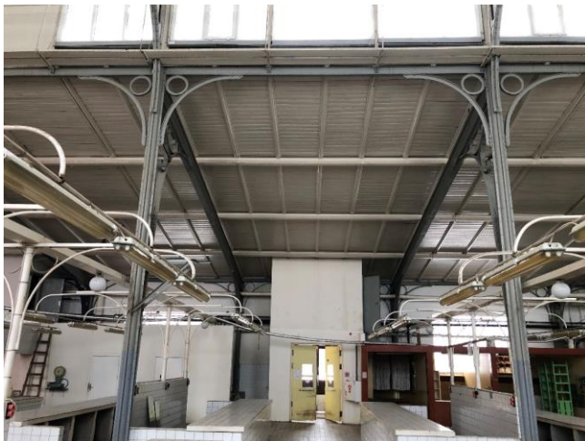
Foto Nr. 8 Zemās jumta daļas konstrukcija.
