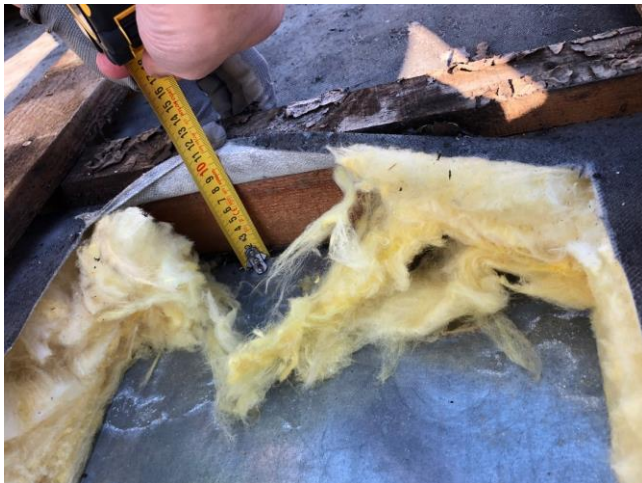
Foto Nr. 20 Garenlatojums virs esošā seguma h-80mm.
